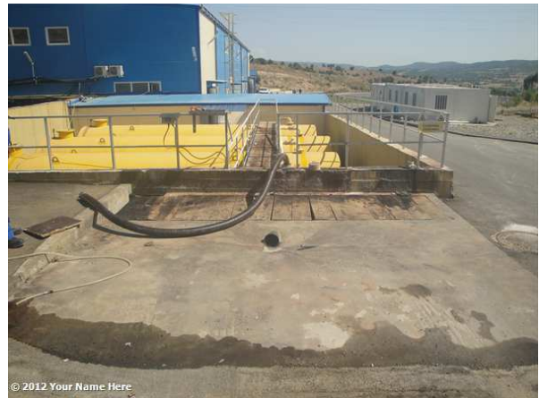
Слика Танвана за резервоари на сулфурна киселина (лево) и пристапна рампа за достава на киселина (десно)
