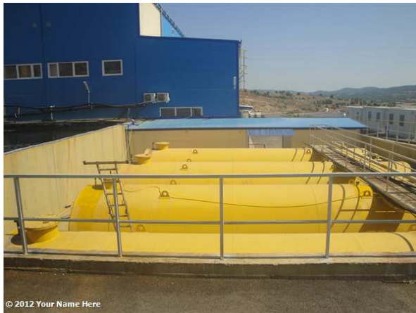
Слика Танвана за резервоари на сулфурна киселина (лево) и пристапна рампа за достава на киселина (десно)
